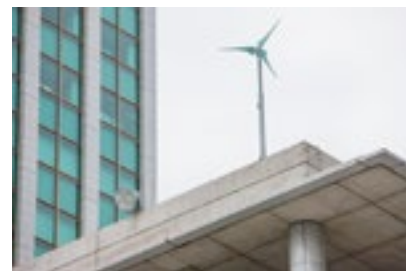
6号館屋上の風力発電設備
